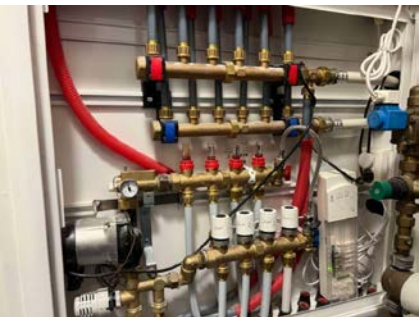
Fordelerskap vannbåren varme
