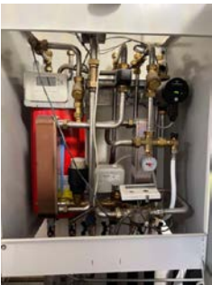
Fordelerskap vannbåren varme
