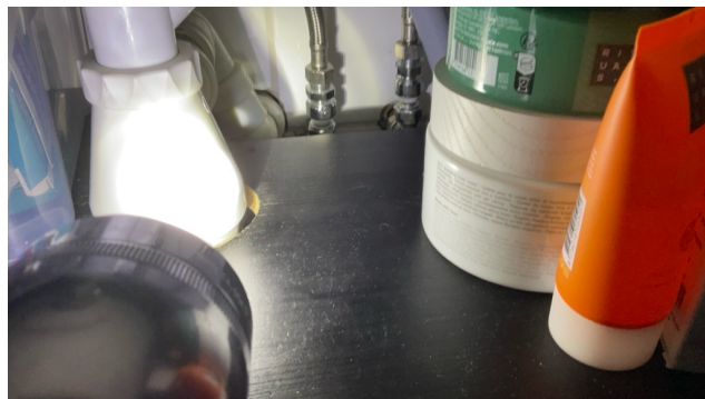
Åpninger i vegg våtsone under servant.
