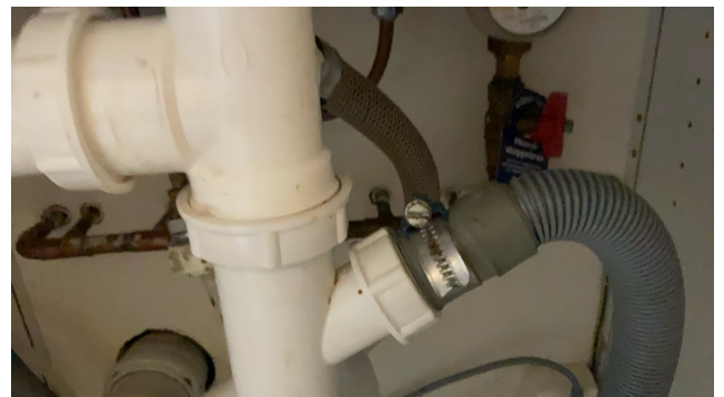
Stoppekran for boenheten i kjøkkenbenk
