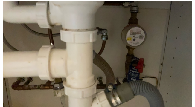
Vannmåler for boligen er i kjøkkenbenk
