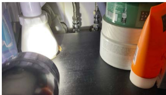
Åpninger i vegg våtsone under servant.
