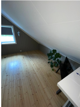
Soverom hvor knevegger er fjernet
