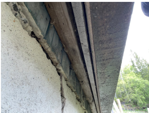
Gammel vegg synlig ved murkrone og hvor det er liten effekt av utført etterisolering.
