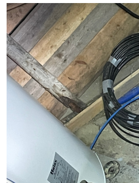
Synlige råteskader i nedre del av treverk mot gulv.
