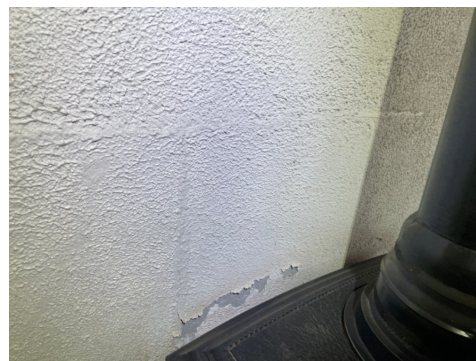
Maling som flaser av bak ovn.
