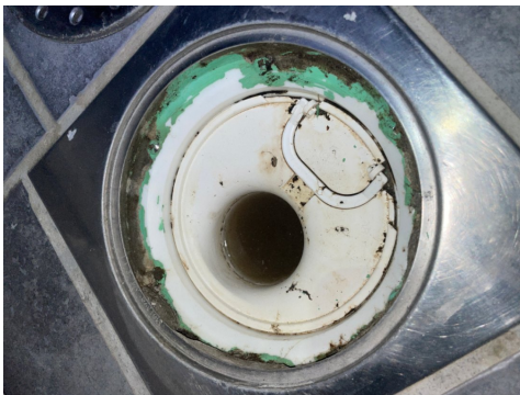
Sluk i dusj. Ufaglig løsning på membran.
