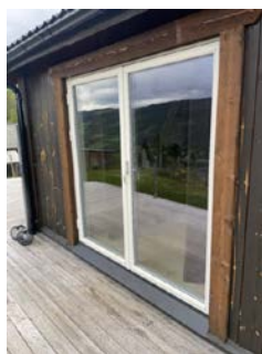
Noe bruksmerker/sår i overflatebehandling.
