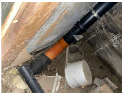
Synlig muggsopp på løsøre.
