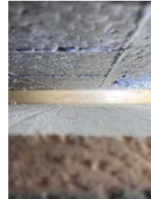
Dette bildet er tatt fra undersiden av panelen og viser den horisontale lekten som stenger for luft og drenering bak ytterkledningen.
