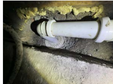
Sluk på fyrrom, avløp fra kjøkken.
