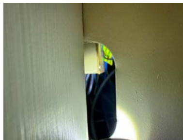
Åpning i sikringsskapet.
