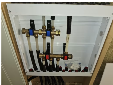
Fordelerskap har blitt skiftet etter befaring.
