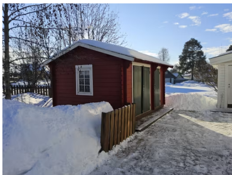
Frittstående bod medfølger boligen.
