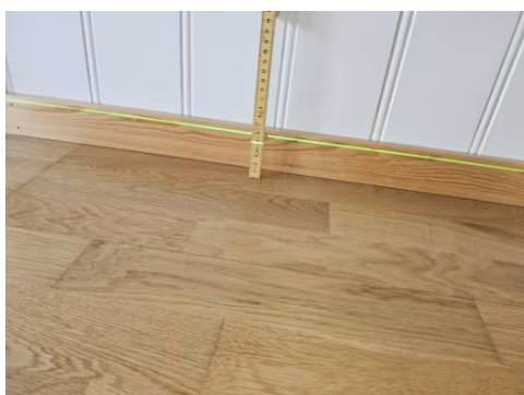
Kontrollmåling ble utført med nivelleringslaser.
