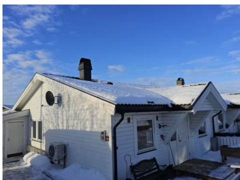
Takkonstruksjonen var snødekt befaringsdagen.
