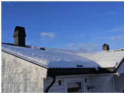
Taktekking var snødekt befaringdagen.
