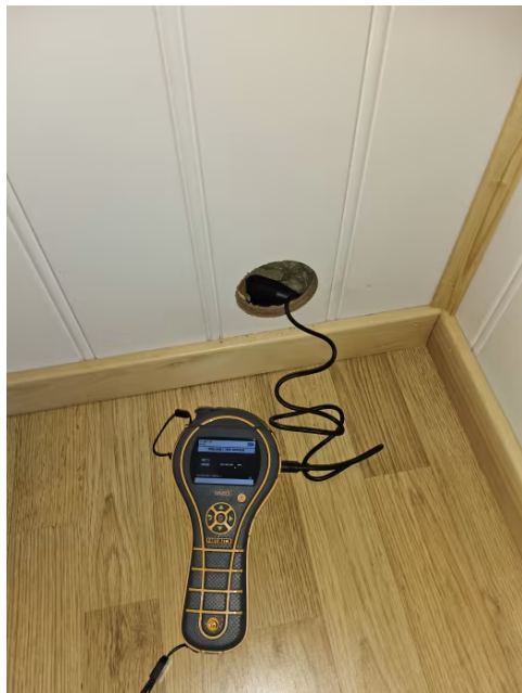
Bilde fra fuktmåling i veggkonstruksjon tilstøtende dusjsone.
