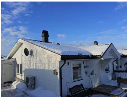
Takkonstruksjonen var snødekt befaringsdagen.
