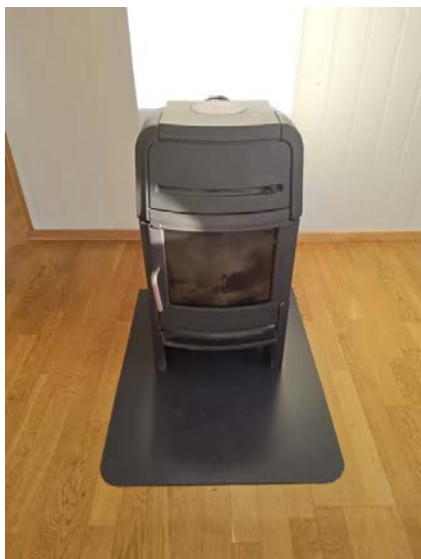
Vedovn med glassdør i stue.
