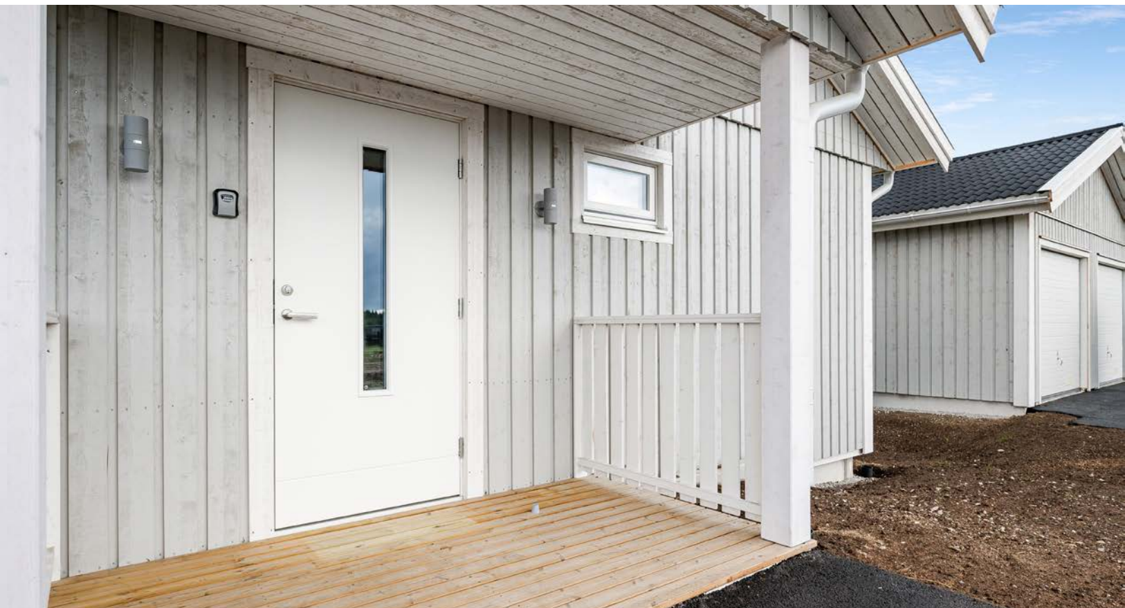
Overbygget inngangsparti med platting, belysning og kodeboks til nøkler.
