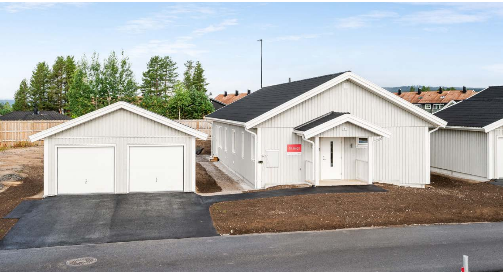
Eiendommen er også bebyggt med en dobbelgarasje på 36 kvm.
