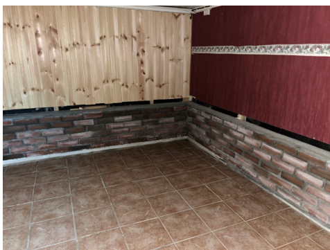
Råteskadet panel fjernet.
