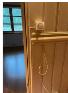
Tynne ledninger til bryter/lamper.
