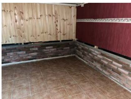
Råteskadet panel fjernet.
