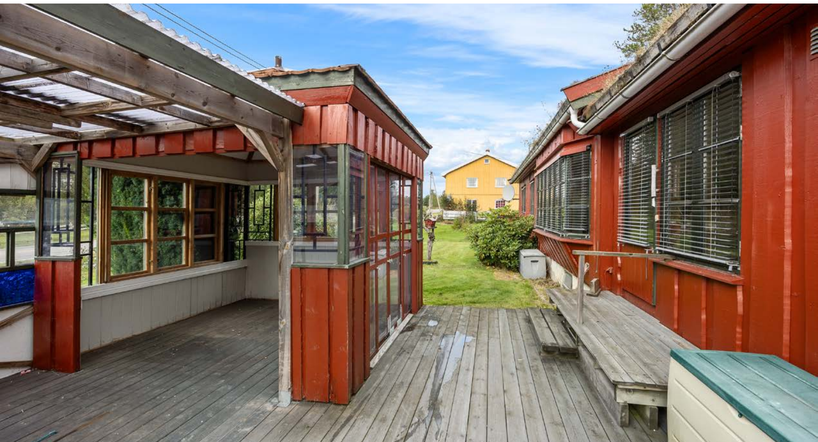
Terrassen har overbygde soner.
