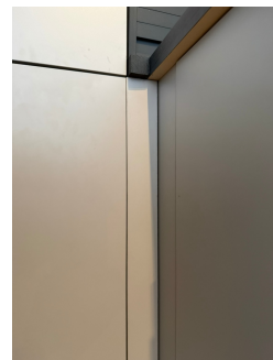
Ujevnheter og gliper i foringer på kjøkken.
