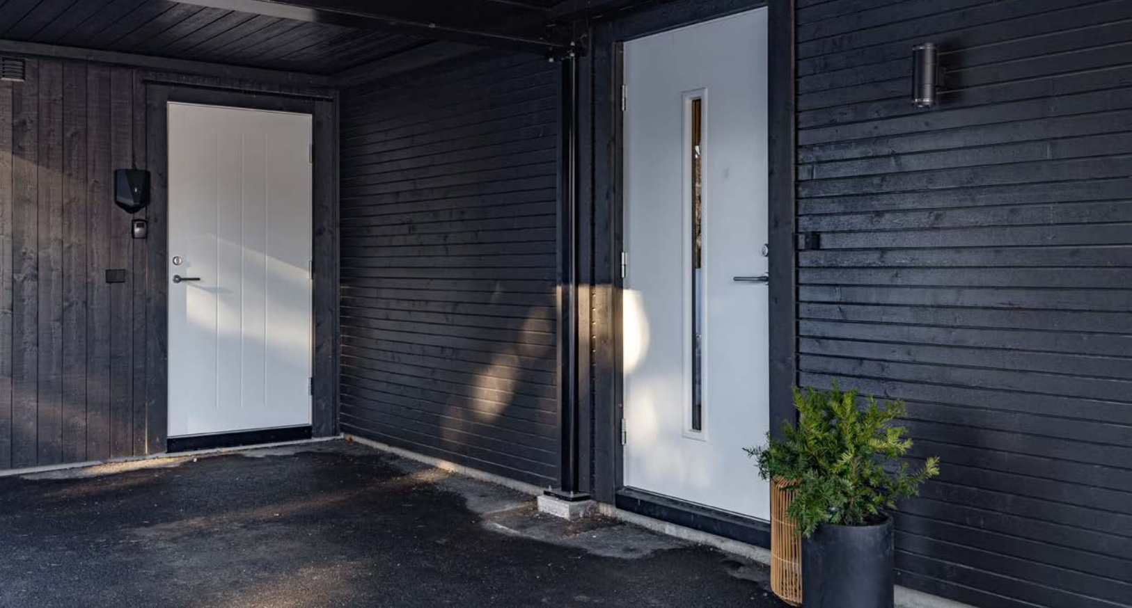
Carport med adkomst til utvendig bod. Det er montert elbil-lader i carporten.
