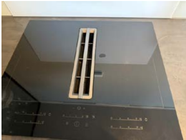
Platetopp med integrert kullfilterventilator.
