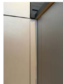
Ujevnheter og gliper i foringer på kjøkken.
