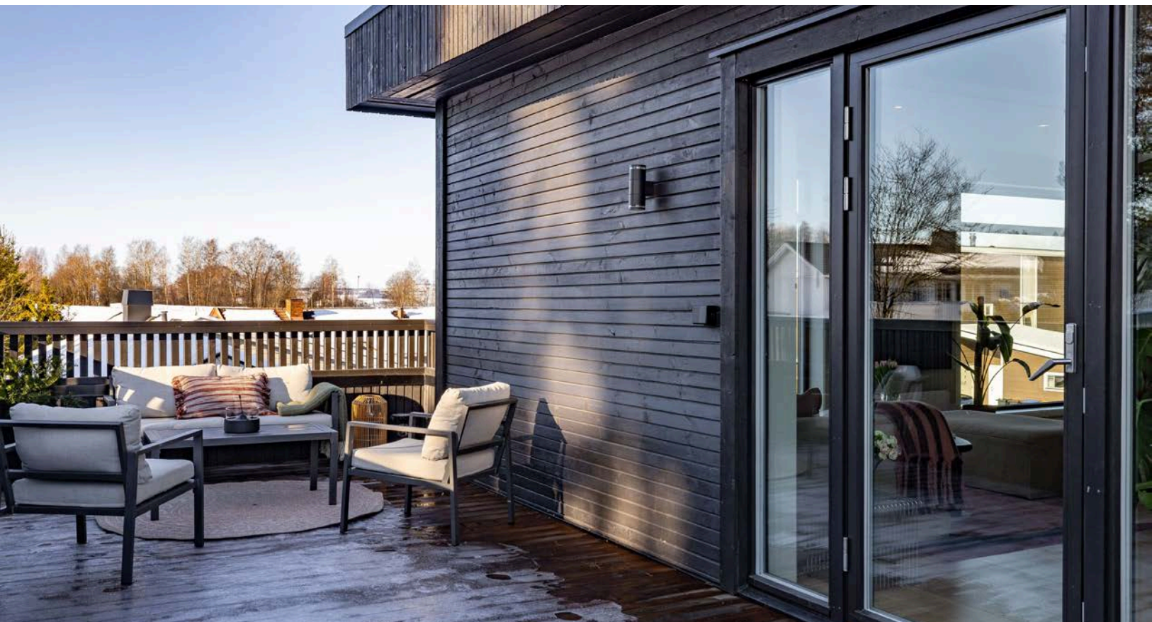
Det er er montert utebelysning og stikkontakter på yttervegg.
