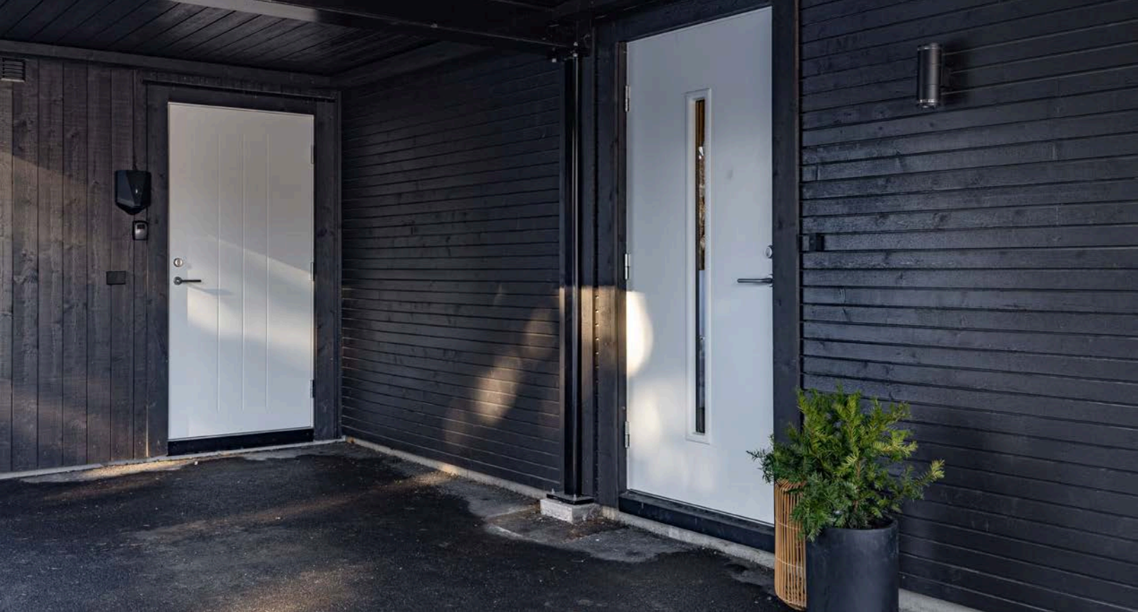
Carport med adgang til utvendig bod. Det er montert elbil-lader i carporten.
