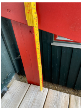
Rekkverkshøyde målt til ca. 74 cm.
