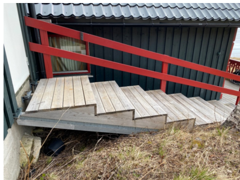
Trapp fra garasje til bolig
