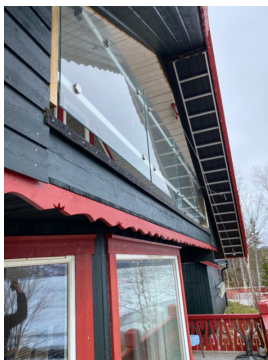
Balkongen er tekket med asfaltapp.
