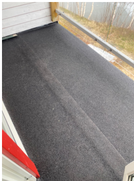
Balkongen er tekket med asfaltapp.
