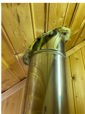
Gjennomføring i tak. Krave rundt rør mangler.
