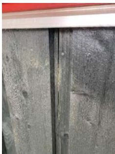
Bordkledning er stedvis oppsprukket.
