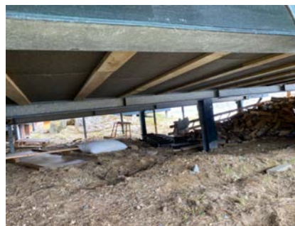
Stubbloft asfaltplater.
