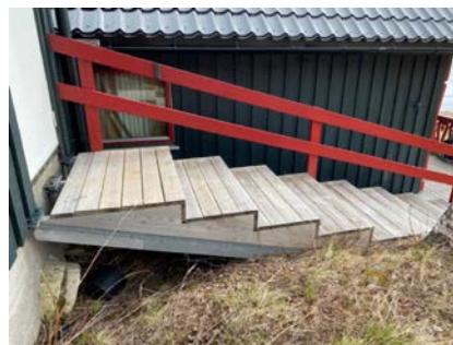
Trapp fra garasje til bolig
