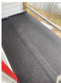
Balkongen er tekket med asfaltpapp.
