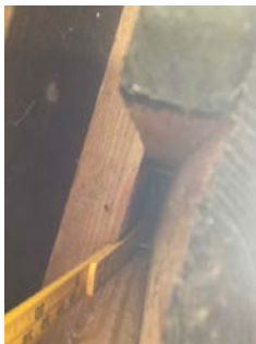
Bordkledning er stedvis oppsprukket.
