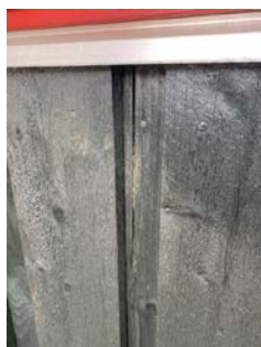
Bordkledning er stedvis oppsprukket.
