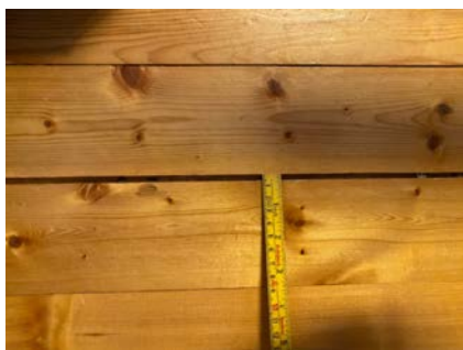
Sprekker/tørke i skjøte furugulv, kjøkken.
