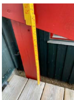
Rekkverkshøyde målt til ca. 74 cm.
