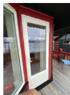
Balkongdør med utgang fra stue.
