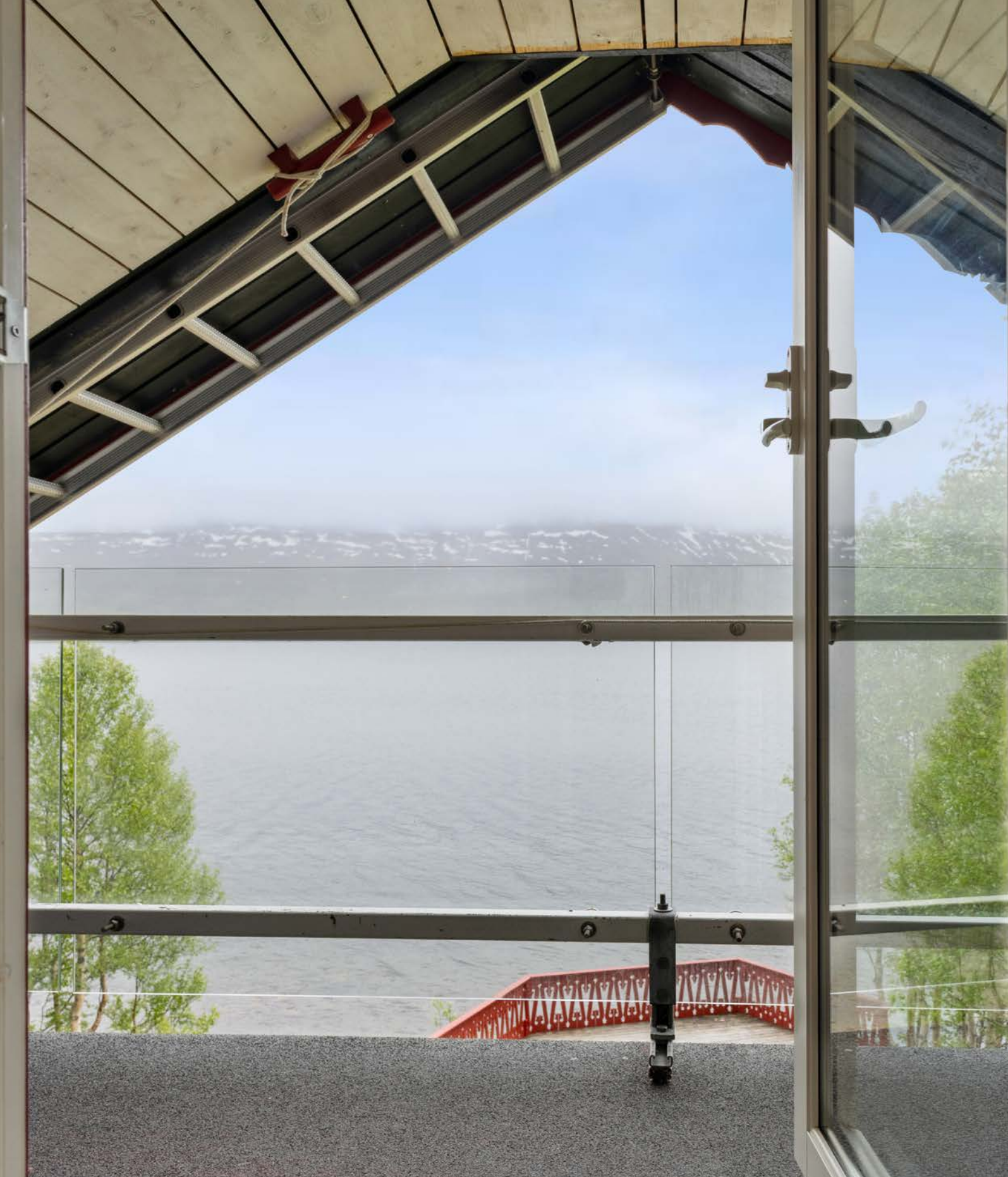
Balkong med adkomst fra soverommet i den tilbygde delen.
