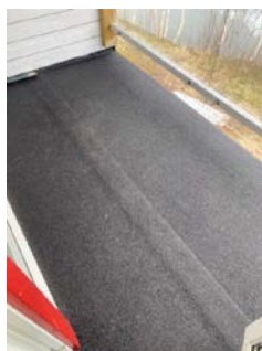
Balkongen er tekket med asfaltpapp.
