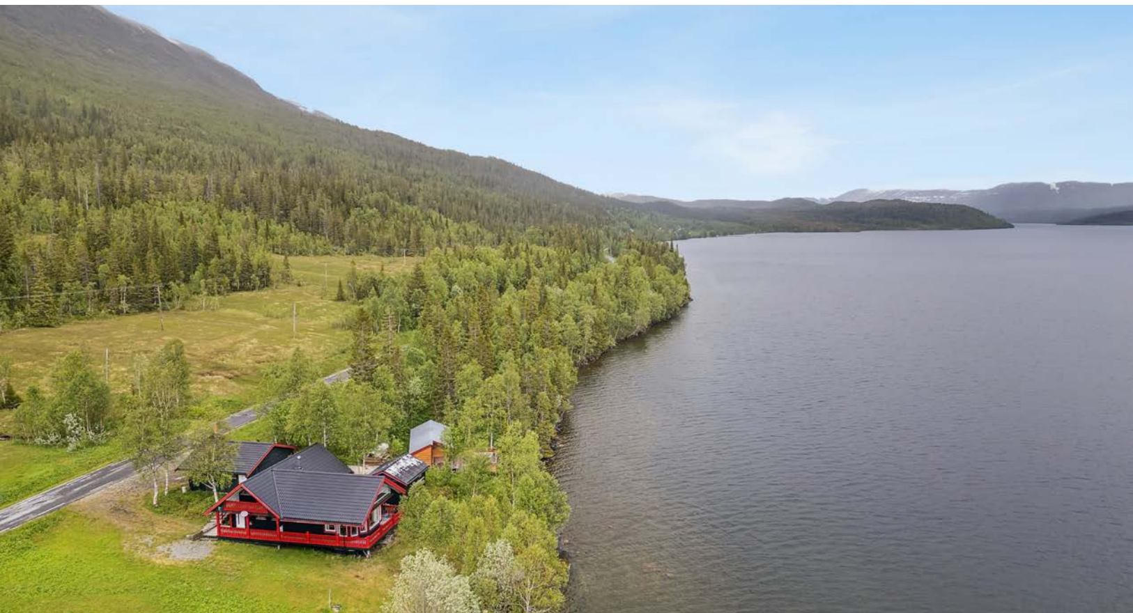
Dronebildet mot nord
