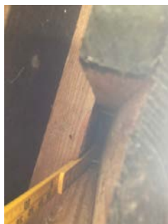
Bordkledning er stedvis oppsprukket.
