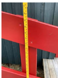
Rekkverkshøyde målt til ca. 74 cm.
