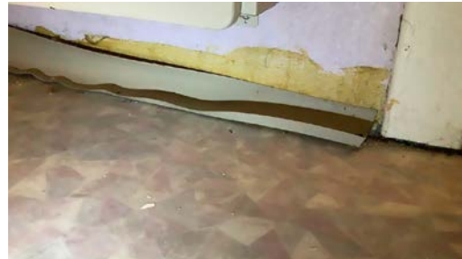
Eksempel på løsnet plastlist.
