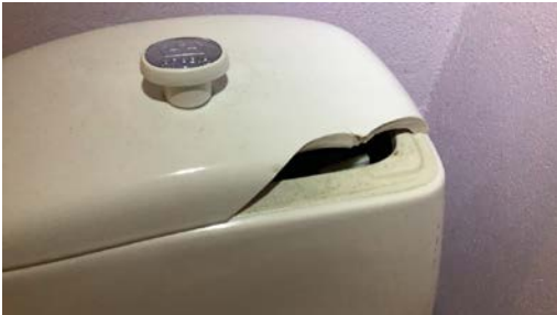
Sprukket topp på sisterner.
