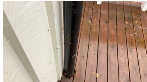
Frostsprengt nedløpsrør.
