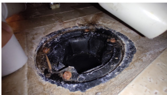
Kontroll av sluk.
