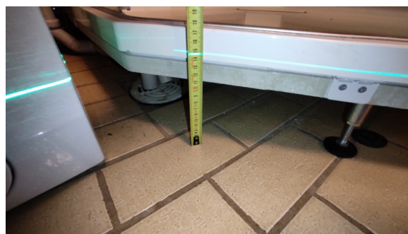
Kontroll av fallforhold.
