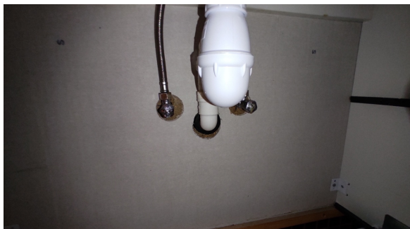
Kontroll av røropplegg.
