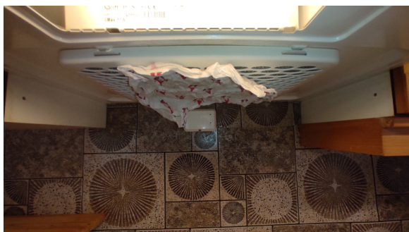
Test av avtrekket.
