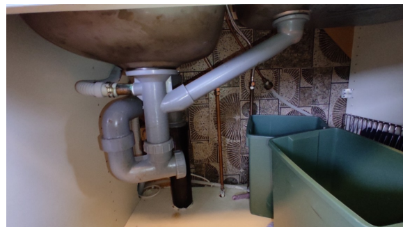
Kontroll av røropplegg.
