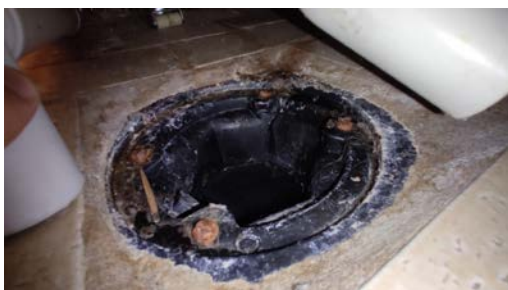
Kontroll av sluk.
