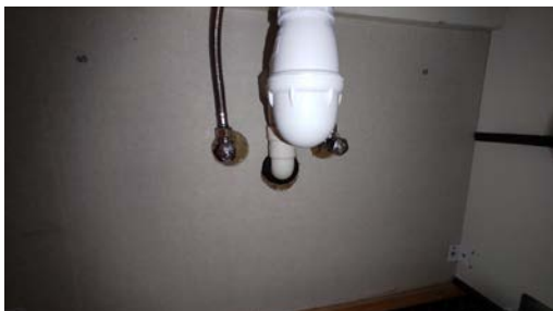
Kontroll av røropplegg.
