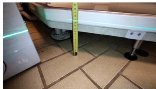
Kontroll av fallforhold.
