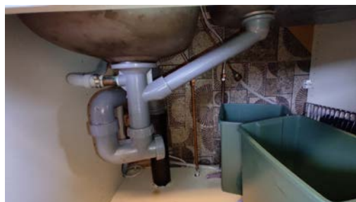
Kontroll av røropplegg.
