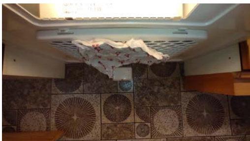
Test av avtrekket.
