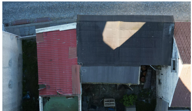
Takplaten i metall har løsnet mot balkong.
