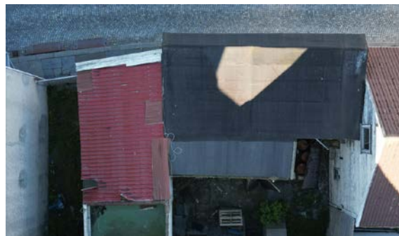
Takplaten i metall har løsnet mot balkong.
