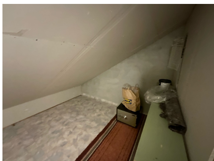
Oversiktsbilde yttervegg Nord-øst
