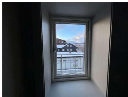
Nytt vindu, rømningsvei.
