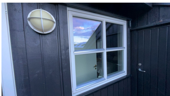
Oversiktsbilde utvendig vindu
