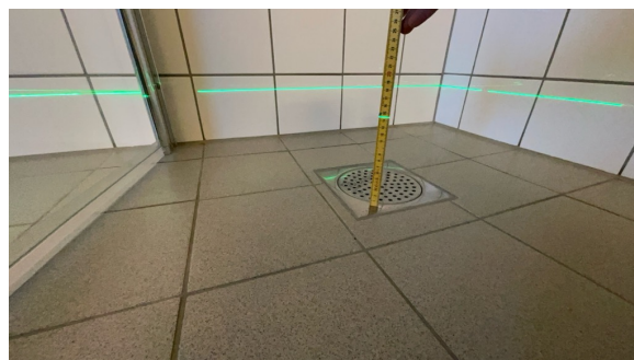
Målt topp slukrist
