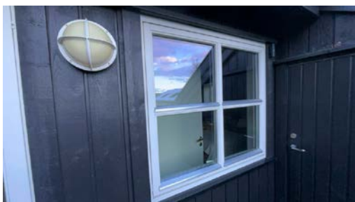
Oversiktsbilde utvendig vindu
