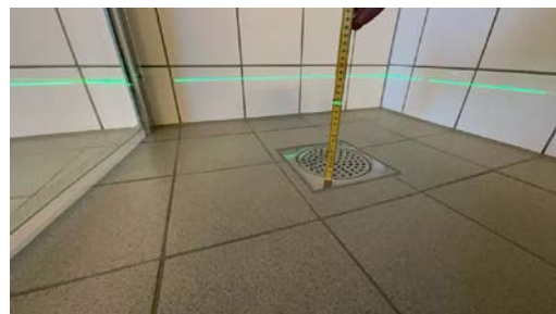
Målt topp slukrist
