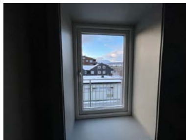
Nytt vindu, rømningsvei.
