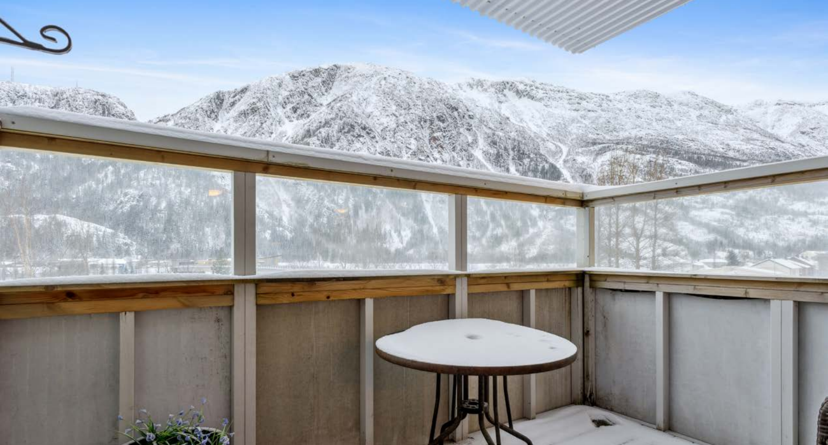
Balkong med malt rekkverk kledd med fasadeplater og plexiglass, har utsikt mot Øyfjellet og Vefsna.
