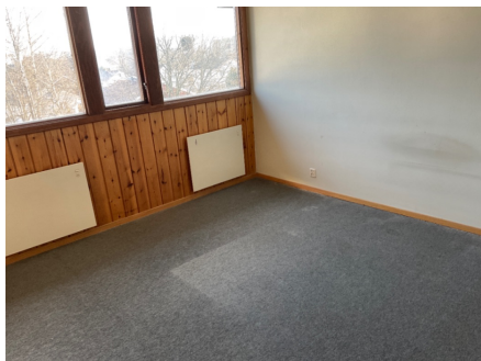
Innvendig og eldre overflater.
