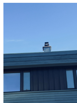
Utvendig pipe, kun visuelt kontrollert fra bakkeplan.
