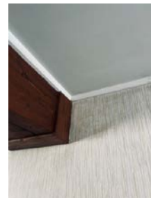
Det aktuelle området i stue i 1. etg.
