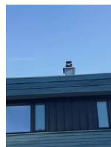
Utvendig pipe, kun visuelt kontrollert fra bakkeplan.
