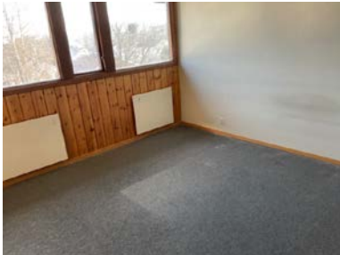
Innvendig og eldre overflater.
