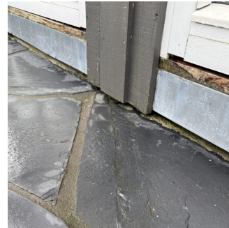
Kledning med liten avstand til plattning
