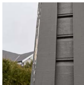
Kledning med liten avstand til plattning
