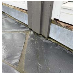
Kledning med liten avstand til plattning
