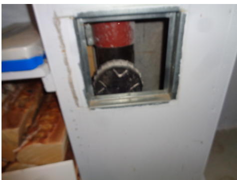
Stakeluke i kjellerrom.
