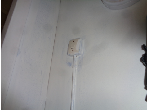
Noe eldre anlegg gjenstår i boligen.
