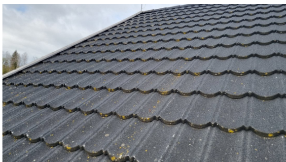
Besiktigelse av taktekke.
