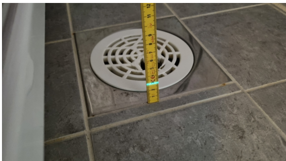
Gulvet har fall til sluk.
