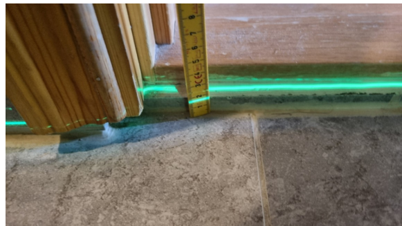
Kontroll av fall.
