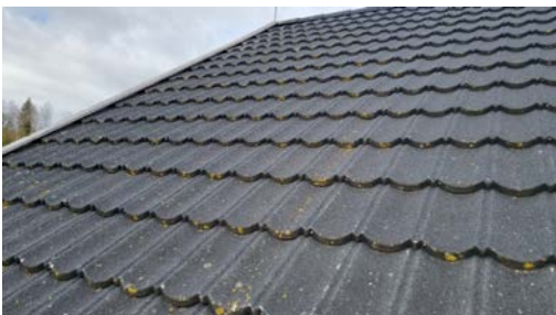
Besiktigelse av taktekke.
