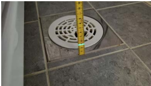
Gulvet har fall til sluk.
