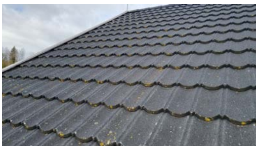
Besiktigelse av taktekke.
