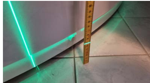
Gulvet er tilnærmet flatt.
