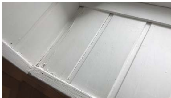
Fuktmerker i vinduskarm i takvinduer
