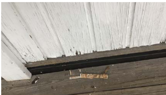
Fukt/råteskade i nedkant loft dør
