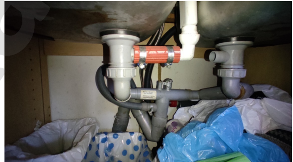
Kontroll av røropplegg.
