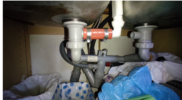
Kontroll av røropplegg.
