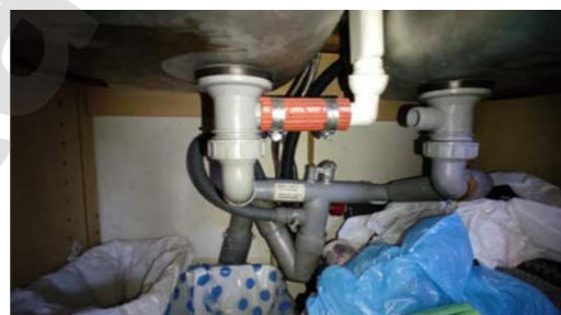
Kontroll av røropplegg.
