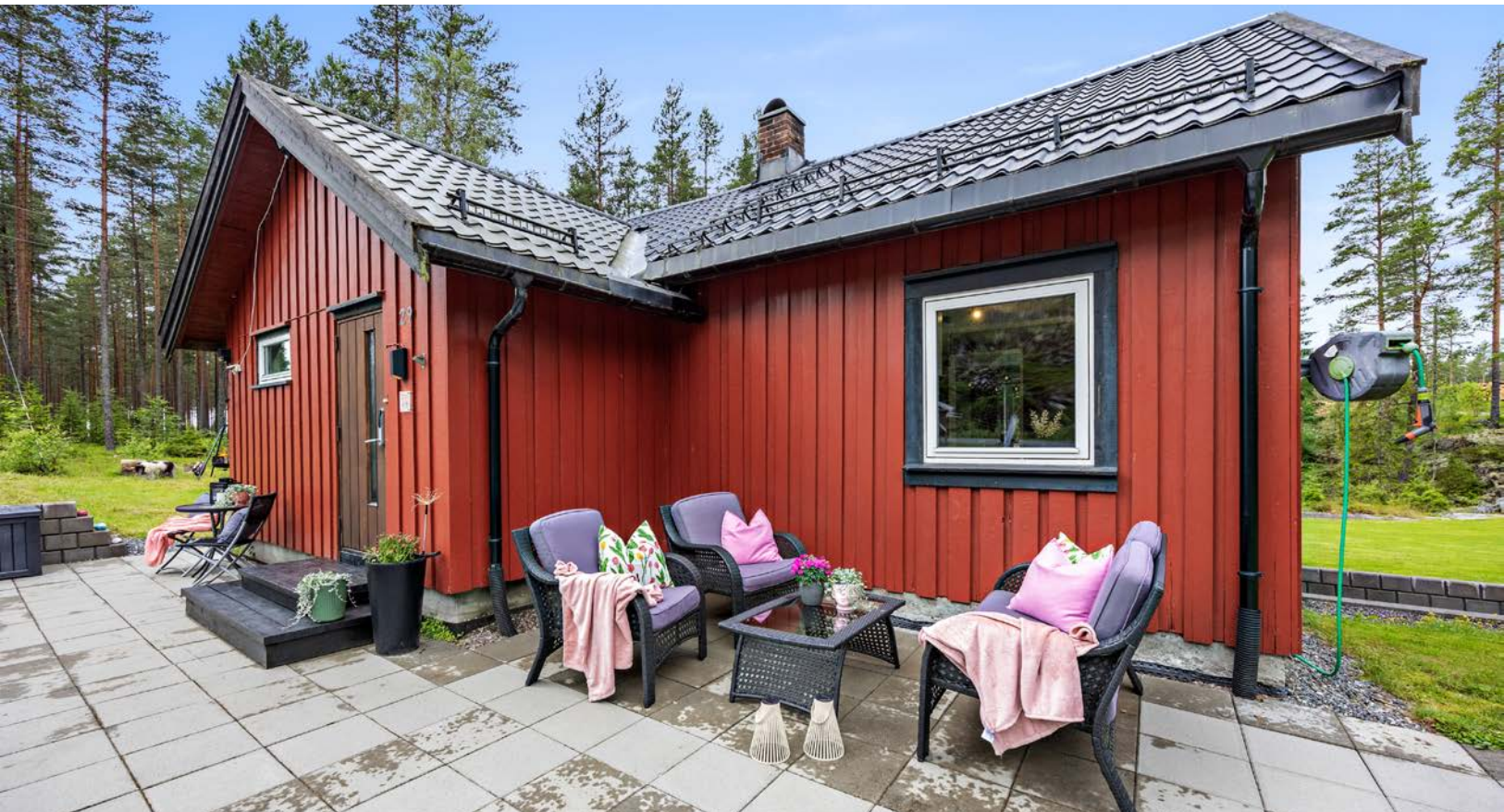
Det ble drenert langs to sider av bygget i 2020.
