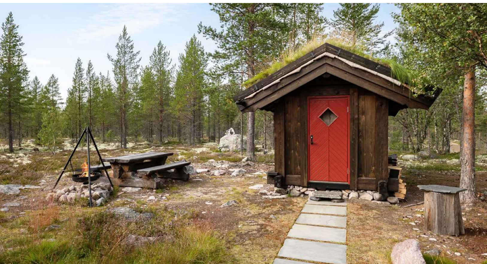
Eiendommen er også bebygd med et isolert anneks på 7m 2 . Annekset ble oppført i 2017/18 og har yttervegger av stavlaft utvendig kledd med stående trekledning samt tak tekket med torv.
