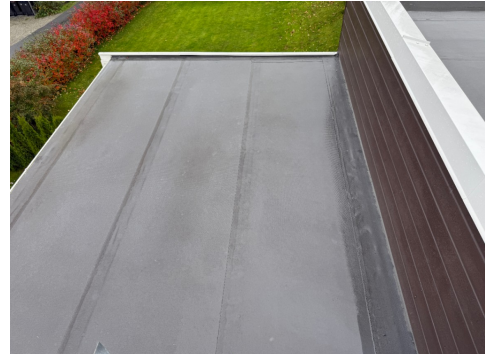
Tak over balkongen
