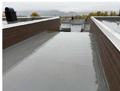
Tak over carport
