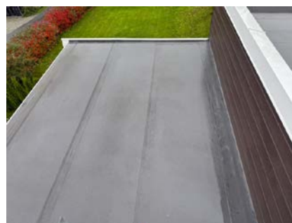
Tak over balkongen
