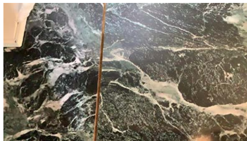
Eksempel på glippe i skjøt mellom baderomsplater.
