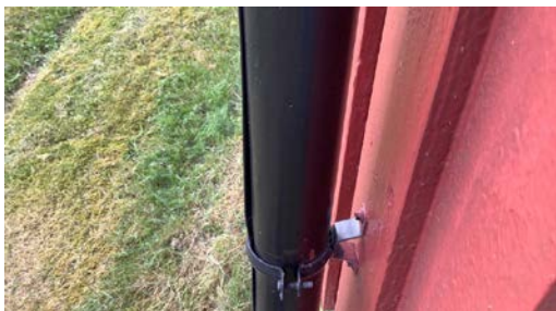
Frostsprenget nedløpsrør.
