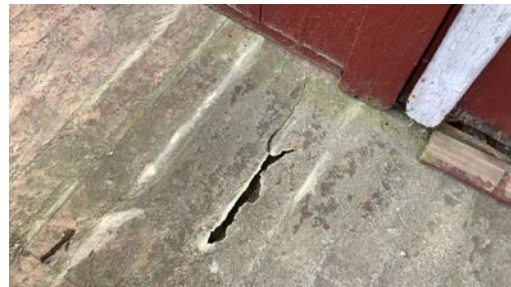
Råteskadet gulv.
