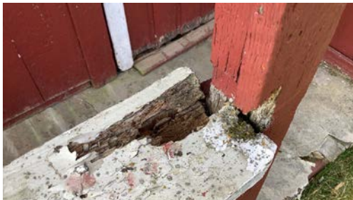
Råteskadet håndløper.
