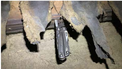
Råteskadet gulvbjelke.
