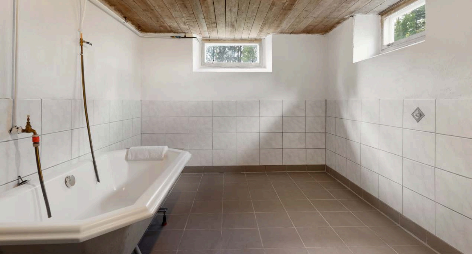
Påbegynt baderom i kjeller med grå fliser på gulv med gulvvarme og delvis flislagte vegger.
