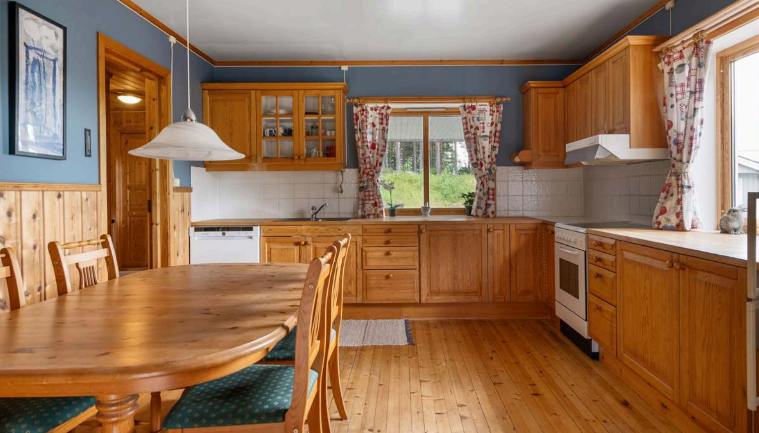
Eldre velholdt kjøkkeninnredning med god skap- og benkeplass. Innredningen har profilerte fronter, heltre benkeplate med nedfelt oppvaskkum og fliser i benkeryggen.
