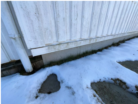
Del av grunnmur - støpt plate på mark.
