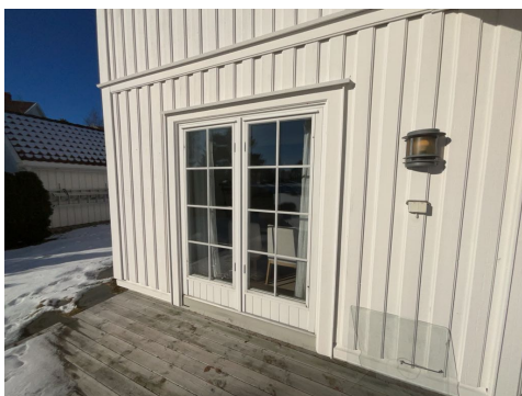
Eksempel på vindu i yttervegg.
