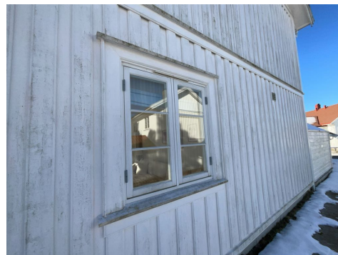
Eksempel på vindu i yttervegg.
