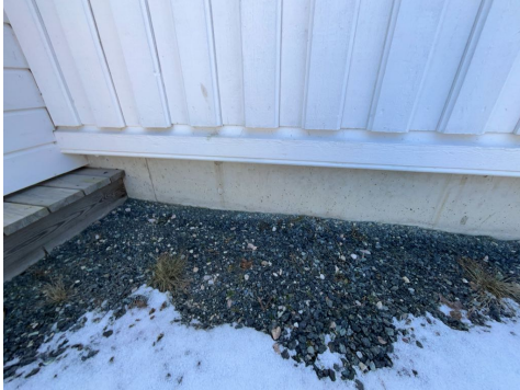
Del av grunnmur - støpt plate på mark.
