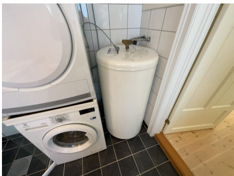
Varmtvannstank.
