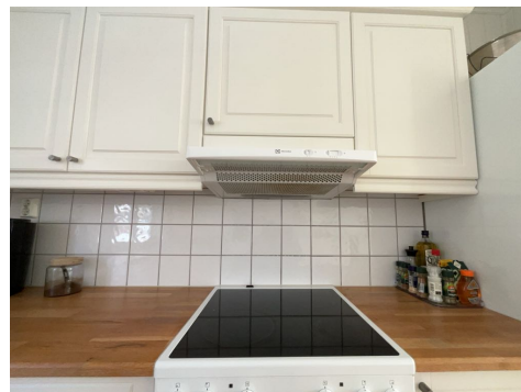
Montert avtrekk over komfyr.
