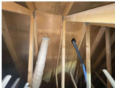
Konstruksjon sett fra loft.
