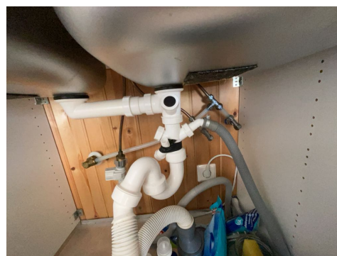
Del av rør til vann.
