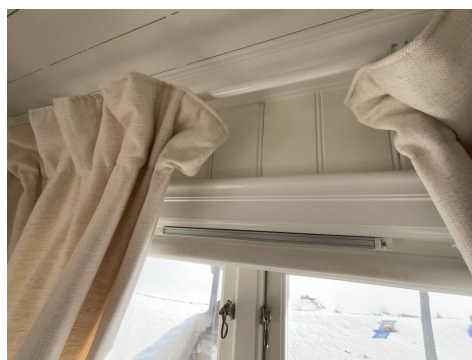
Eksempel på montert ventil i vindu.
