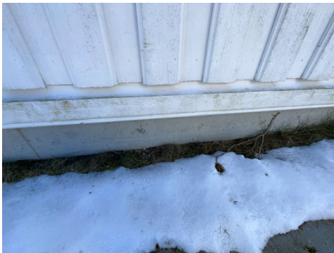
Del av grunnmur - støpt plate på mark.
