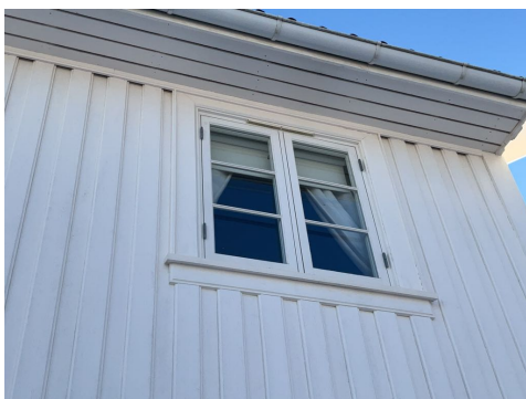
Eksempel på vindu i yttervegg.
