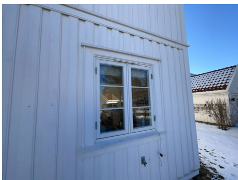
Eksempel på vindu i yttervegg.
