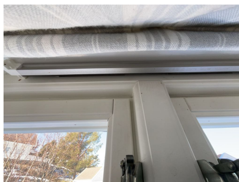
Eksempel på montert ventil i vindu.
