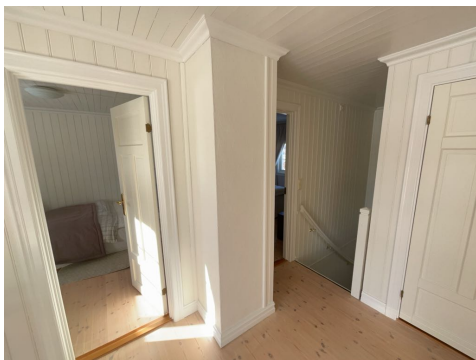
Del av pipe i 2 etasje
