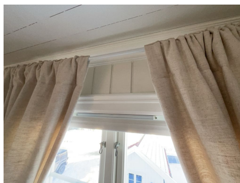
Eksempel på montert ventil i vindu.
