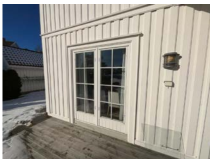
Eksempel på vindu i yttervegg.
