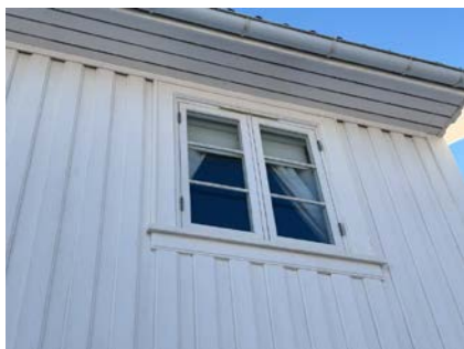
Eksempel på vindu i yttervegg.
