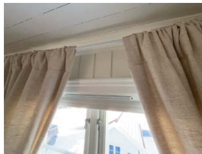
Eksempel på montert ventil i vindu.
