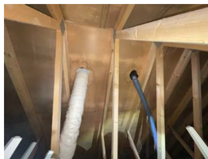
Konstruksjon sett fra loft.
