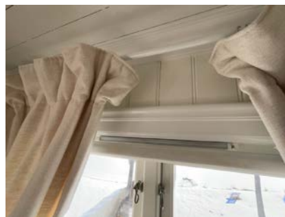
Eksempel på montert ventil i vindu.
