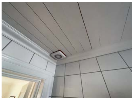
Montert avtrekk i tak.
