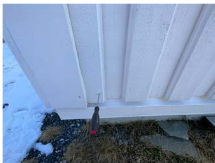
Stikk kontroll av vegger er utført.
