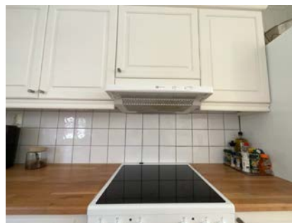
Montert avtrekk over komfyr.
