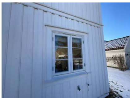
Eksempel på vindu i yttervegg.
