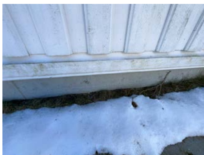
Del av grunnmur - støpt plate på mark.
