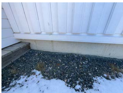
Del av grunnmur - støpt plate på mark.
