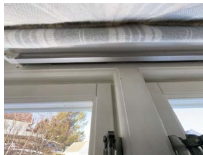
Eksempel på montert ventil i vindu.
