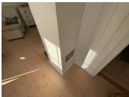
Del av pipe i 1 etasje og feieluke.
