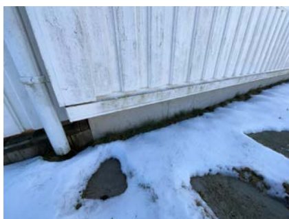
Del av grunnmur - støpt plate på mark.
