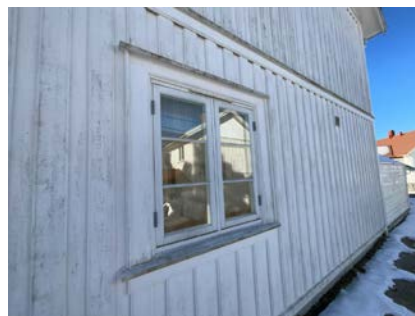
Eksempel på vindu i yttervegg.
