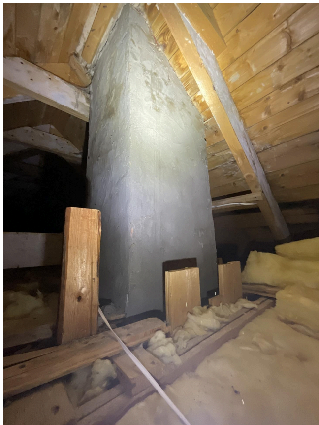
Pipe på kaldloft
