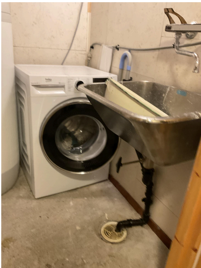
Opplegg på vaskerom
