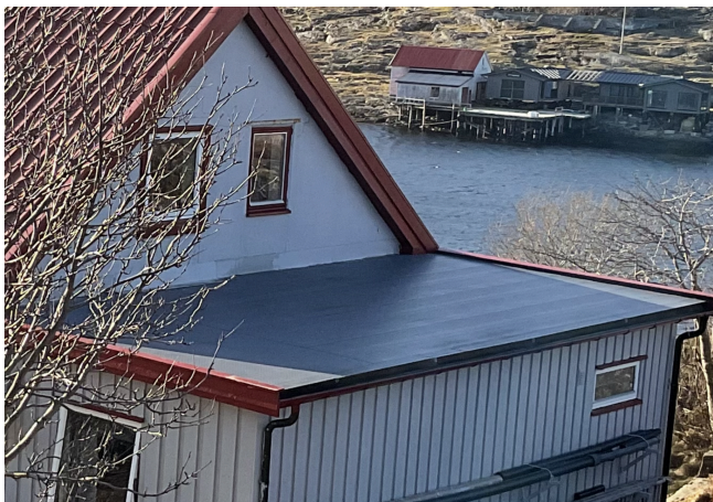
Tilbygg 2 med svak helling er tekt med sveiset duk
